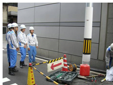
電柱撤去工事現場見学
