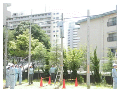
電柱昇降実習
