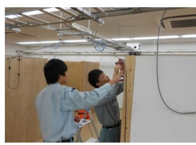
光引込工事実習
