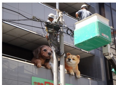
柱上作業見学
