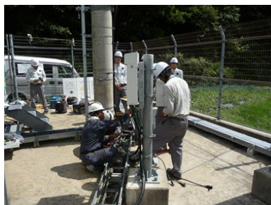
モバイル設備工事現場見学
