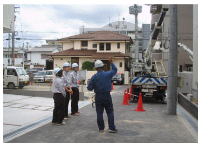
工事現場見学
