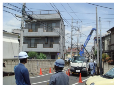
工事現場見学
