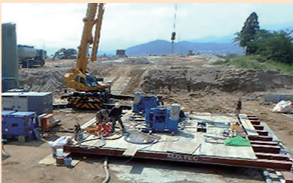
建物をしっかり支えるための地盤改良
