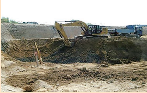
重機を使った造成1
