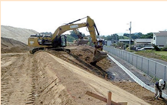
重機を使った造成2
