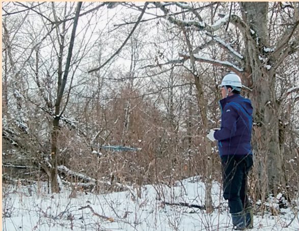
写真6 ドローンによる山林内ケーブル敷設作業 須郷センタ長によるドローン操作模様
