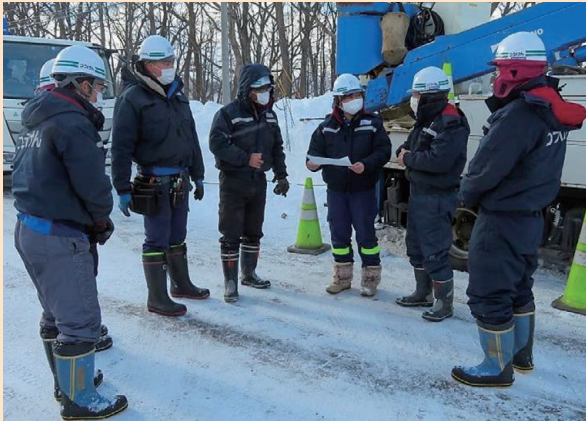
写真2 施工前ミーティング 右から3番目が向館さんです。 寒い冬の工事では防寒着を重ね着してもかじかみます。
