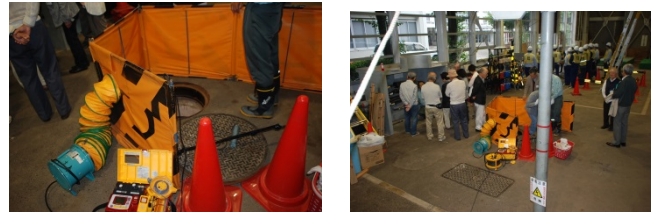
写真3. マンホール入孔前の酸素欠乏測定 [左側写真] 及び安全研修に係る説明・写真右上危険体感安全研修科 [右側写真]
