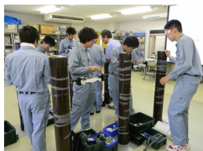
光ケーブル接続の実習模様〔西日本研修センター〕
