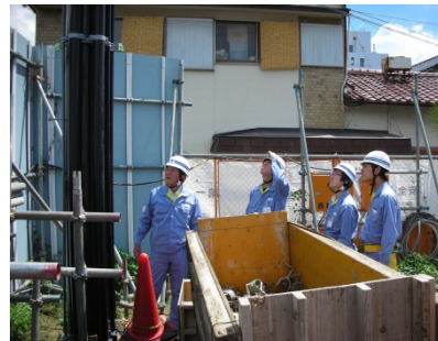
ビル建築現場での調査業務体験
