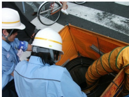
マンホール内工事の見学
