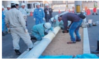
電混防護シートの取付け
