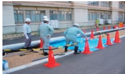
保安施設の設置
