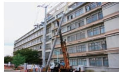
クレーンを使用した建柱
