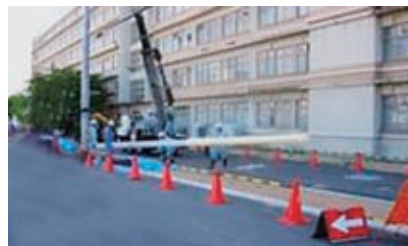
クレーンによる電柱の積降ろし
