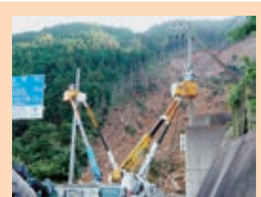
写真8 台風12号による災害での復旧作業
