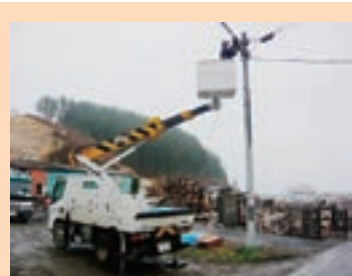
写真7 東日本大震災での復旧作業
