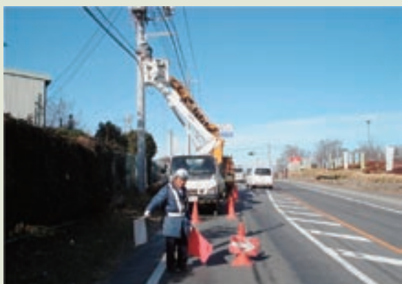
写真3 歩道が設置されていない道路上での工事
