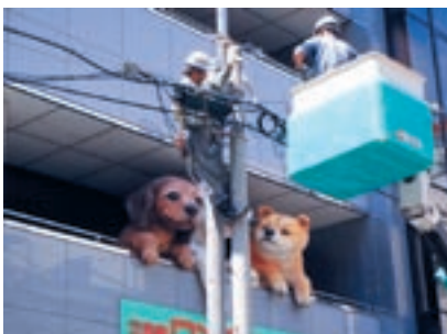
柱上作業見学
