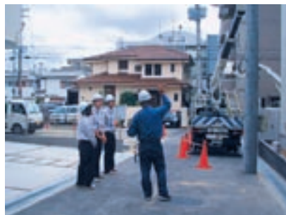
工事現場見学
