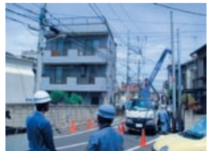
工事現場見学
