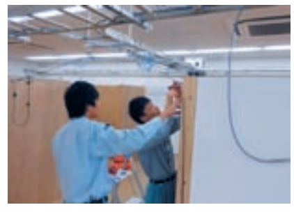
光引込工事実習
