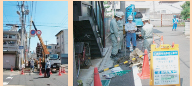
写真5 施工現場への安全パトロール
