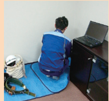
写真10 お客様宅工事
