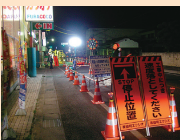
写真1 夜間施工状況
