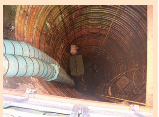
写真2 φ4000mmライナープレート立坑掘削状況
