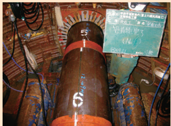
写真4 推進管接続完了(推進管押込み状況)
