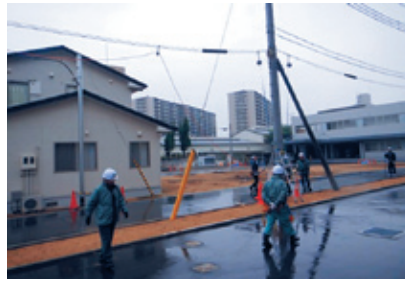
写真8 通信線路建設技術科（架空）
