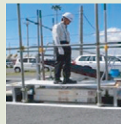
図5 スレート屋根材踏抜き危険体験・体感
