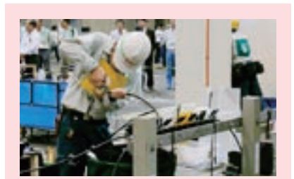
写真10 光アクセス設備施工競技(1)
