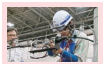
写真8 複合設備施工競技(1)
