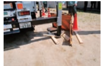
写真10-① 地盤養生不良危険体感
