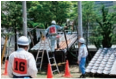
写真5-② 瓦、スレート屋根歩行体感
