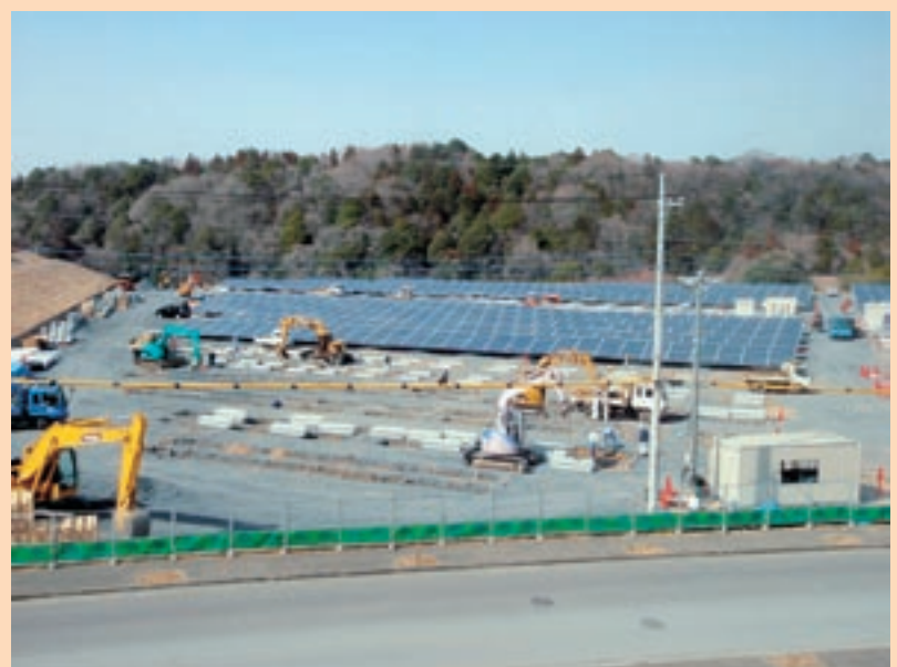
写真2 基礎設置工事
