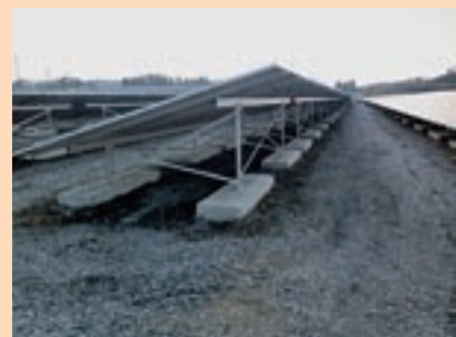
⑧ 設置完了
