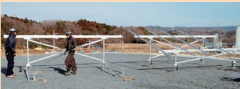
④ 架台設置
