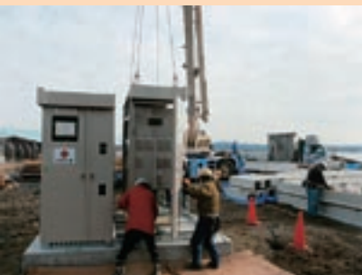
⑥ 機器設置
