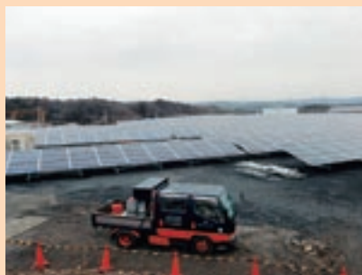
⑦ パネル設置
