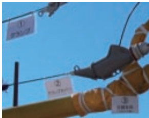
i) 高圧線クランプカバーの構造
