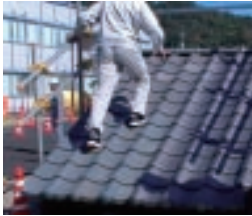
i) 屋根上用シューズによる瓦屋根上作業体感
