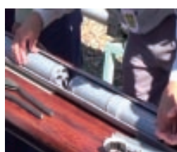
ii) PITライニング工法の説明
