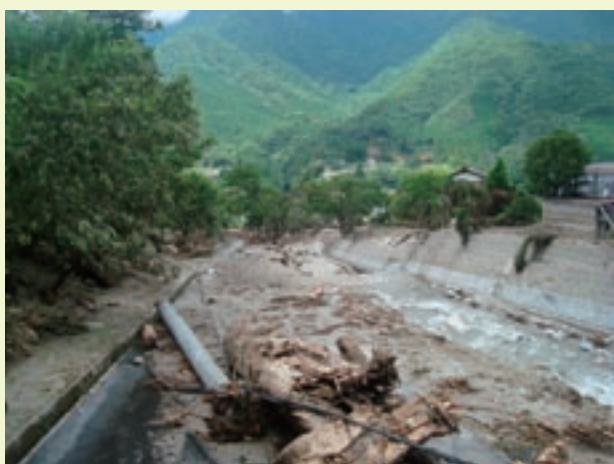
写真1 2015年7月9日長野県南木曾郡で発生した土石流で土砂と一緒に流された電柱
