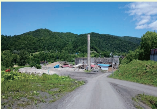
写真3 東亜建材工業(株) 夕張処理場
