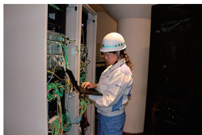
既存通信機器への設定変更および確認作業
