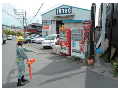
地中探査機を使用した現場調査
