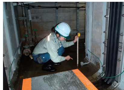
とう道内の排水ポンプ故障による浸水確認状況
