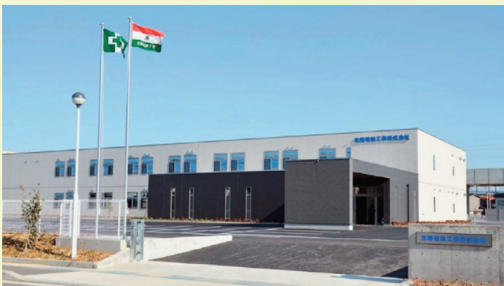
図1 新社屋「西金沢ビル」外観
