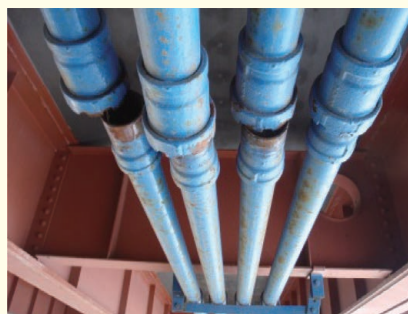
写真 橋桁の変位による被害例
