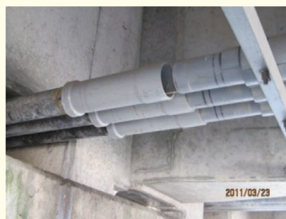
写真 橋桁の変位による被害例
