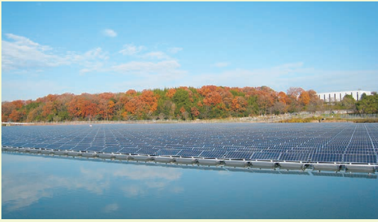
水面に浮かぶ太陽光パネル
