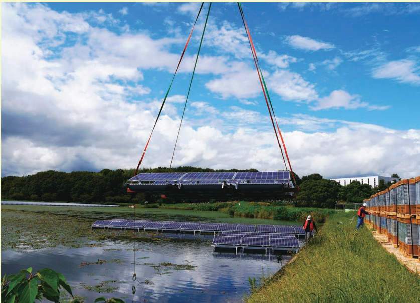
ユニットを水面に降ろす様子
