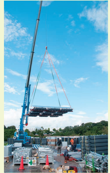
クレーンで吊り上げる
