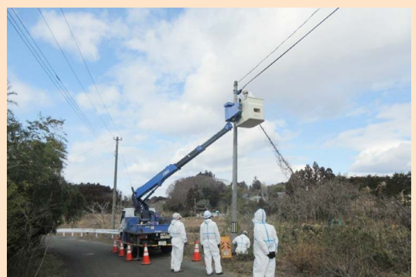
写真8 帰還困難区域での接続作業
