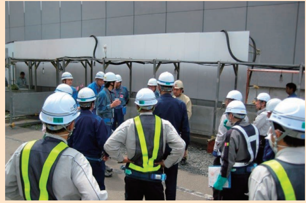
写真2 NTT様・東京電力様・大手ゼネコン様との現場調査
