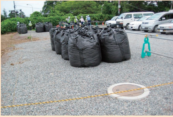
写真1 ハンドホール前に置かれた汚染物
