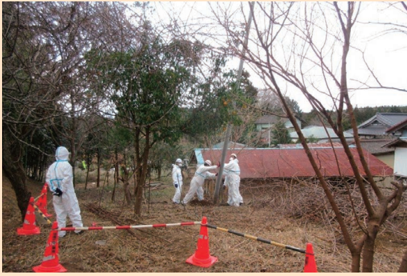
写真6 帰還困難区域での抜柱作業
