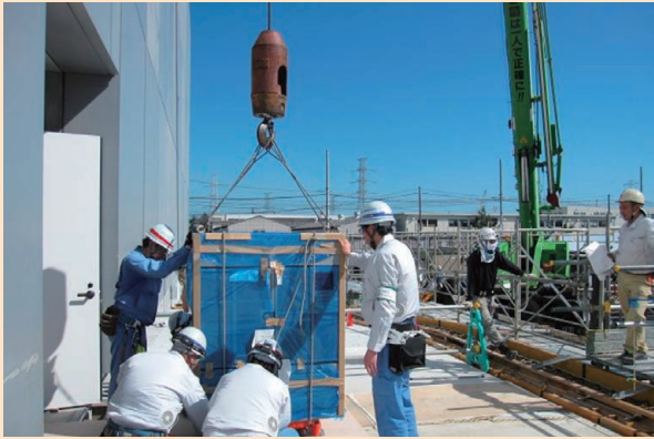
写真3 屋外用RSBMの搬入状況
