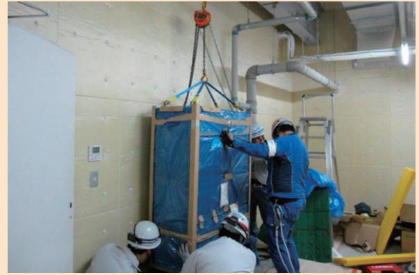
写真4 屋外用RSBMの室内据え付け状況
