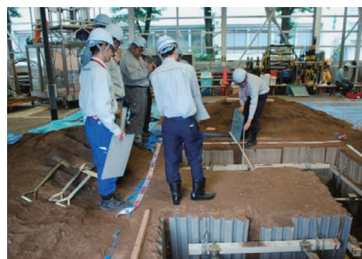
写真5 埋設物試掘および記録写真撮影
