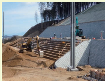
写真6 段切、PC版設置
