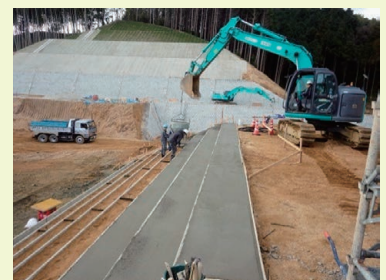
写真7 コンクリート打設
