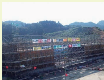
写真15 今治～小松自動車道延伸工事
