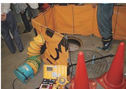
写真3 マンホール入孔前の酸素濃度測定
