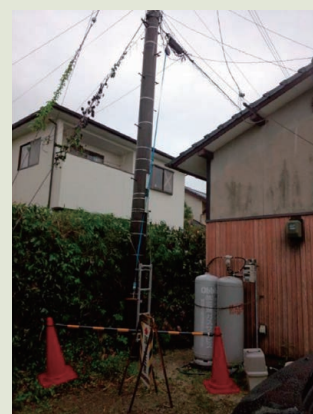
写真2 高所作業車が使用できない場所
