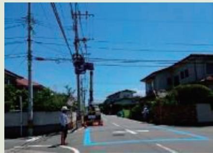
写真1 道路横断箇所
