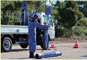
写真14 小型トラッククレーンの操作実演
