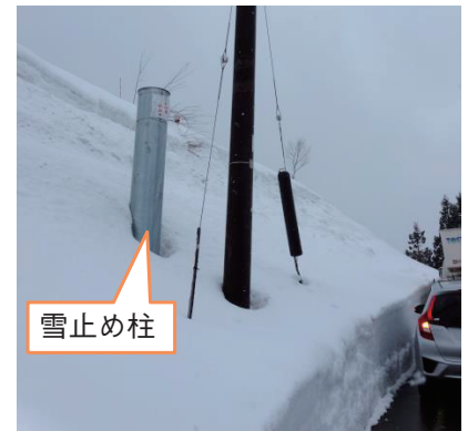
図6 現用電柱における雪止め柱の適用トライアル
