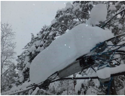
図2 架空設備への着雪の様子
