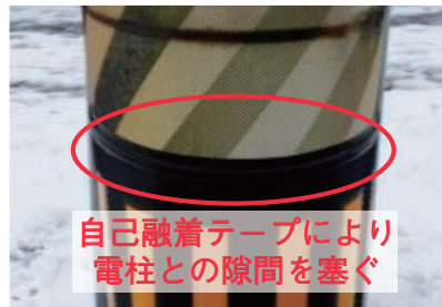
図4 バンド破断の検証状況
