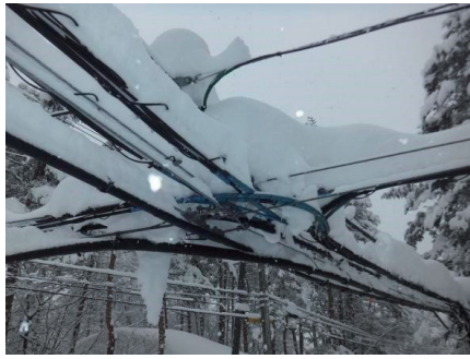
図2 架空設備への着雪の様子
