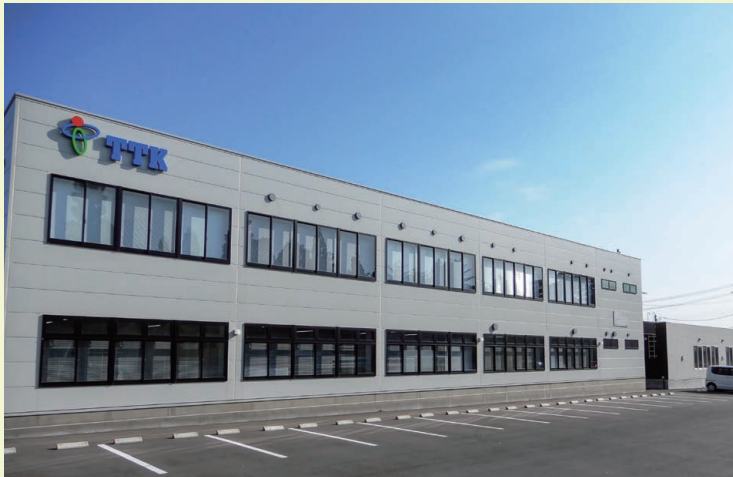
写真1 エキスパートセンタ外観
