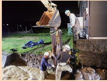
写真6 軽量鋼矢板打設
