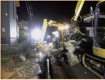
写真5 崩落床板取壊し
