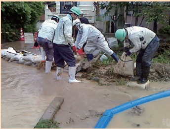
写真7 L型水路撤去
