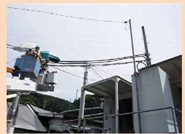
写真4 ケーブル接続
