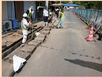
写真8 側溝の泥出し
