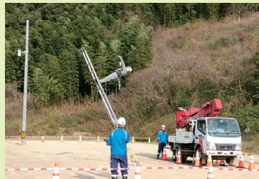
写真14 張力の反動による転落事故実演
