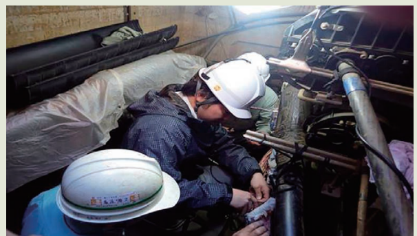
写真3 スタルベスケーブルの接続研修
