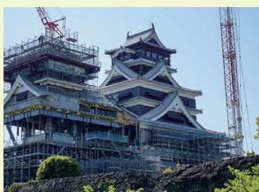
復旧・復興工事が進む熊本城天守閣
