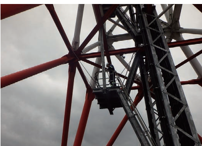
鉄塔作業実習
