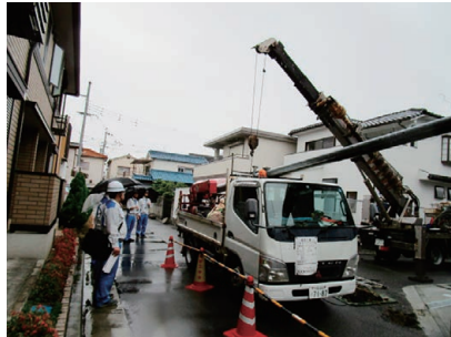
建柱作業見学
