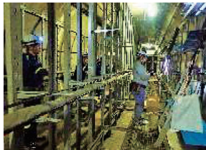
とう道補修工事見学
