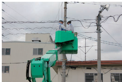
高所作業車実習
