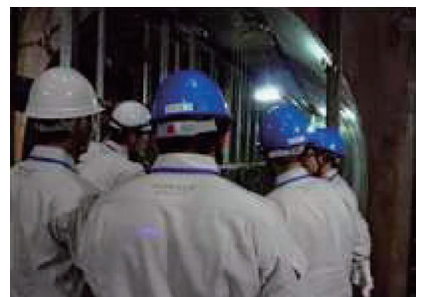
とう道補修工事見学
