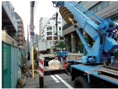
建柱作業見学
