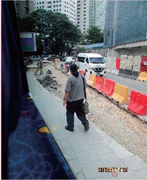
道路工事現場を横切る歩行者
