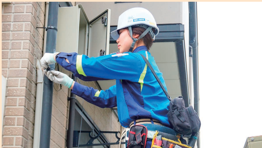
現場での作業風景
