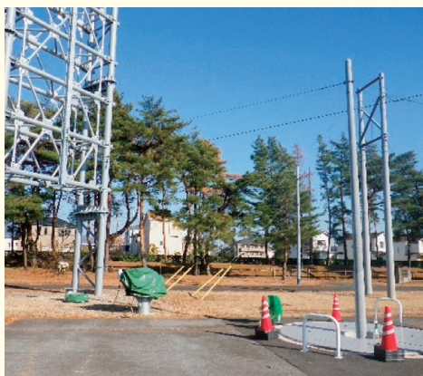
図2 架空構造物総合検証設備
