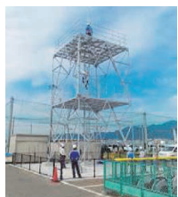
写真1 訓練用鉄塔昇降
