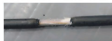
(b) 引きちぎられたケーブル外被
