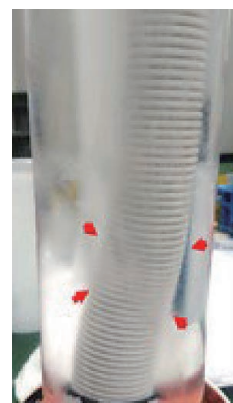
図5 応力が集中し変形したPF管の一部
