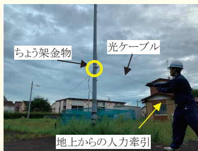
写真1 施工性検証の様子
