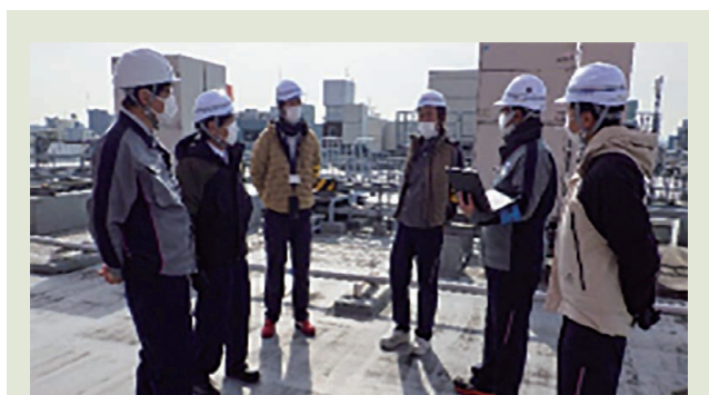
写真8 モバイル工事現場の社長パトロール
