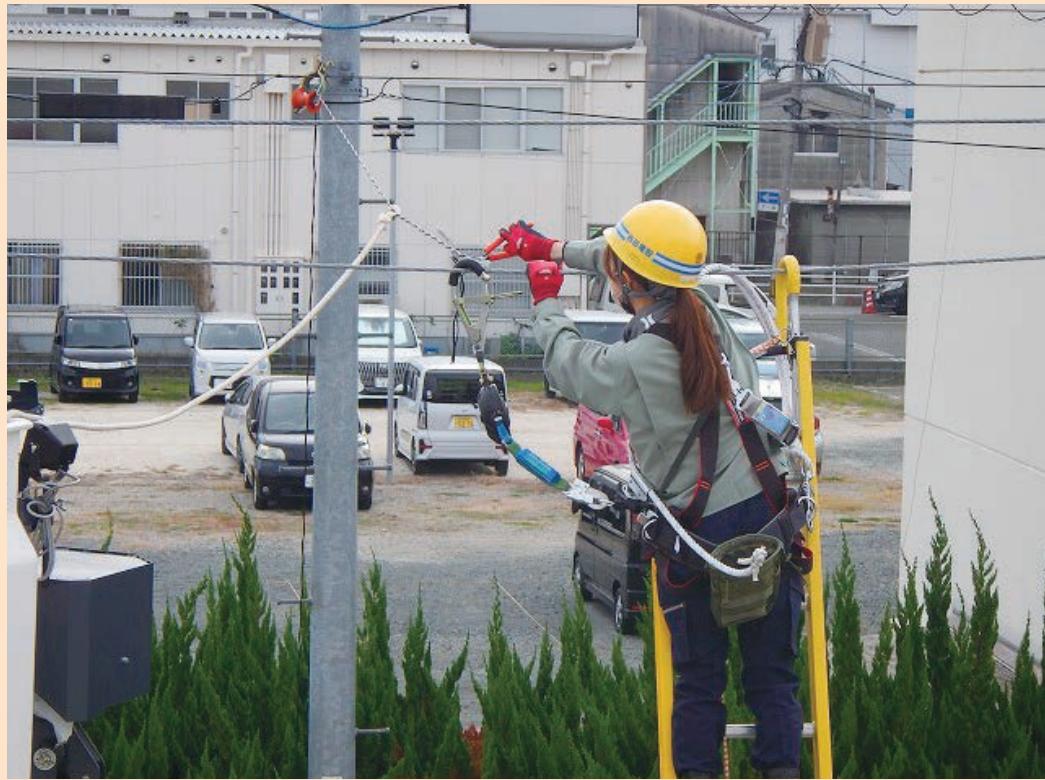
写真2 直営工事研修での危険体感研修
