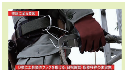
写真6 電柱からの墜落
