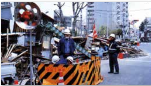
応急復旧工事は、架空ケーブルの仮接続、撤去等の他、地下ケーブルのガス漏洩孔修理もかなり発生した
