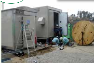
元の位置に応急復旧中の交換機収容装置
