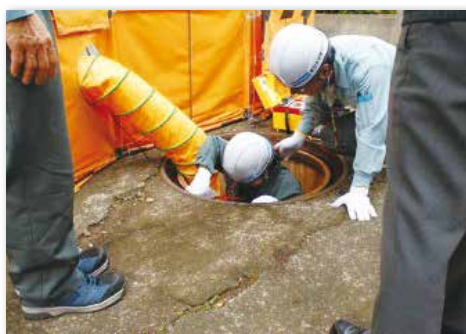
マンホール作業実習
