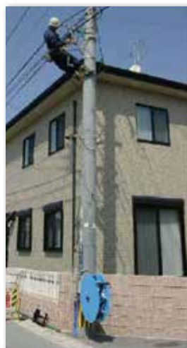
CCH新設作業状況
