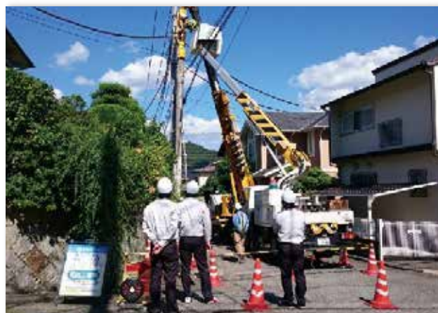
高所作業見学
