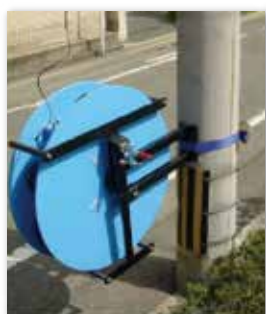
電柱根元への設置状況
