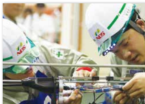
メタル設備施工部門
