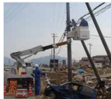
架空ケーブル接続
