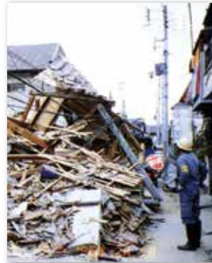
民家の倒壊により架空線路設備が被災したものが多かった
