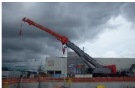
ラフタークレーンによる施工
