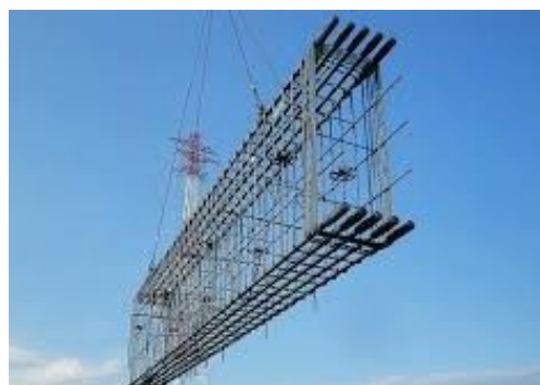
梁鉄筋地組取付
