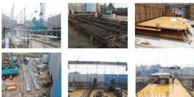
地組(足場・型枠・鉄筋)のイメージ
