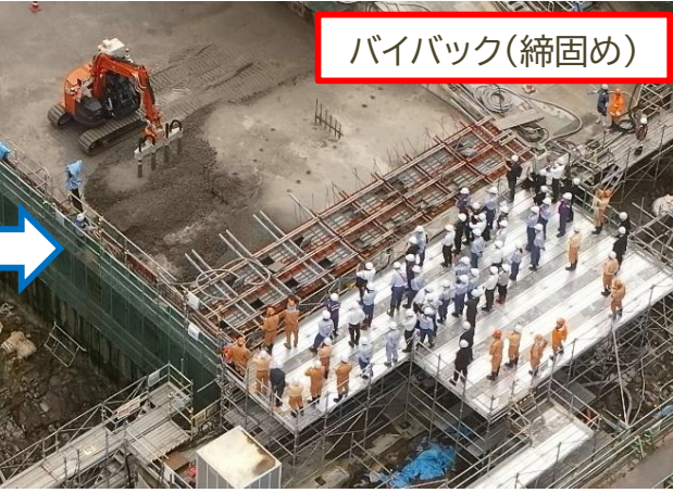
バイバックによるコンクリート締固め動作の自動化を実現
