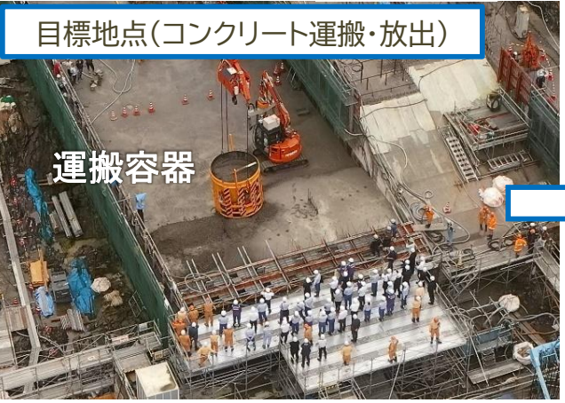
目標地点までケーブルクレーンの自律運転で揺動を抑えて運搬・放出
