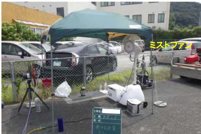
現場休憩所に日除けテント・ミストファン設置
