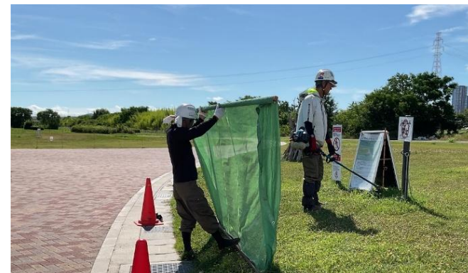
高水敷除草工実施状況
