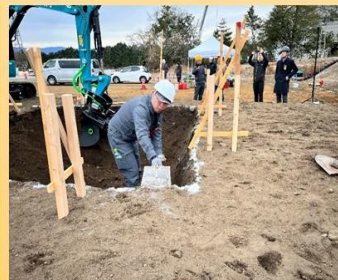
端部はスコップを用いて人力作業
