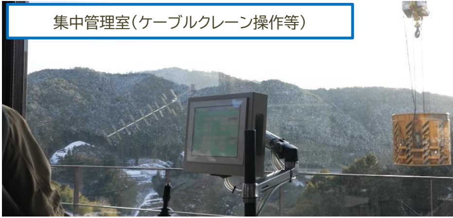
熟練した作業員の運転技術を自律運転で再現
