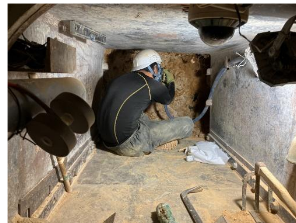
パイプルーフ補助工法 (箱型ルーフ人力掘削状況)
